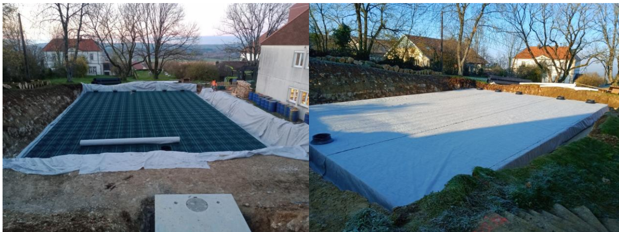
Exemple de bassin stockage-infiltration (BSI)
