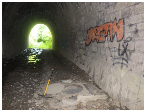
Tunnel - Cadre non scellé
