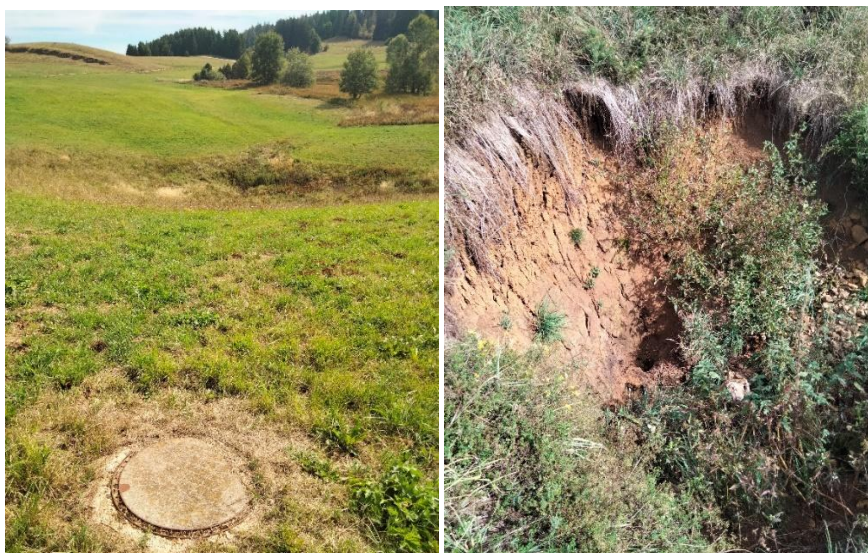
Point de rejet du réseau pluvial
