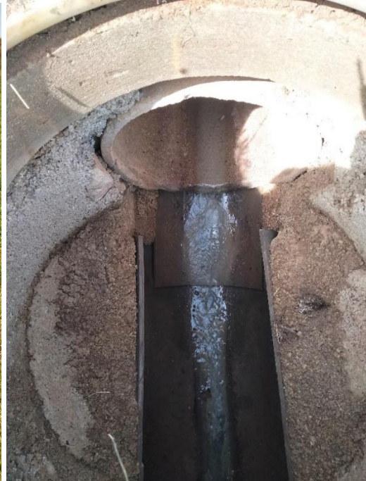
Regard en amont du rejet du réseau pluvial – Point de mesure projeté
