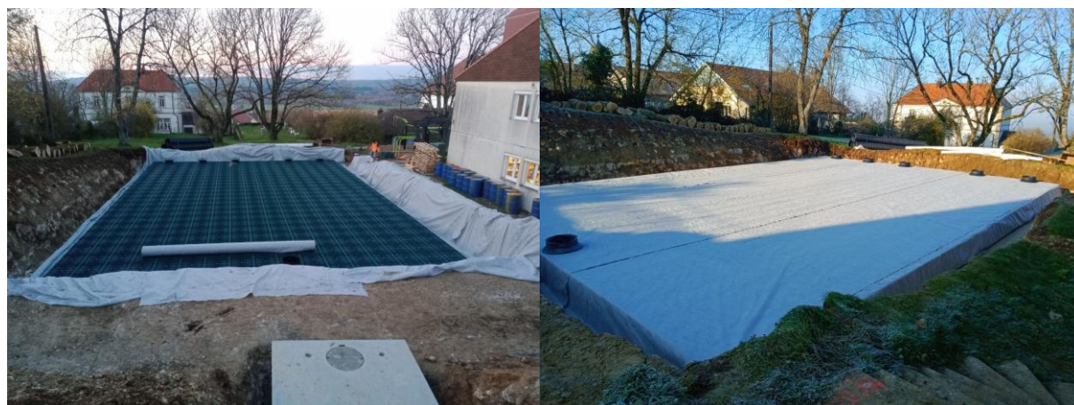
Exemple de bassin stockage-infiltration (BSI)
