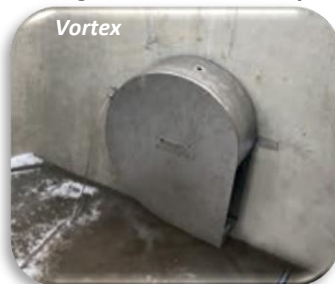
Système de cloison avec orifice
