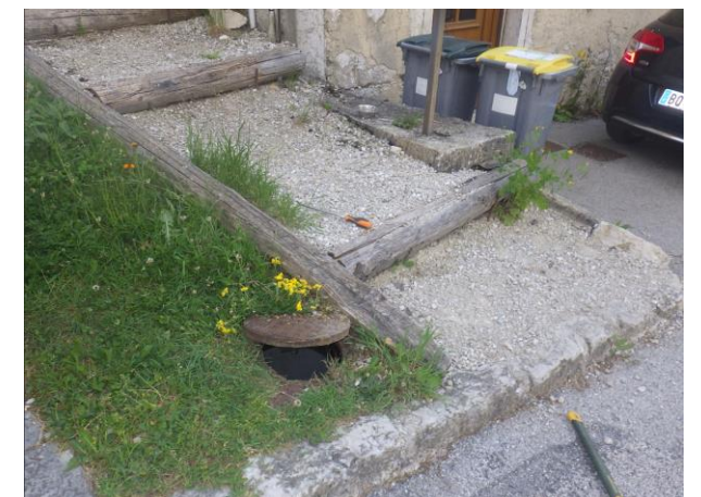
Réseau unitaire Rue de l'Eglise
