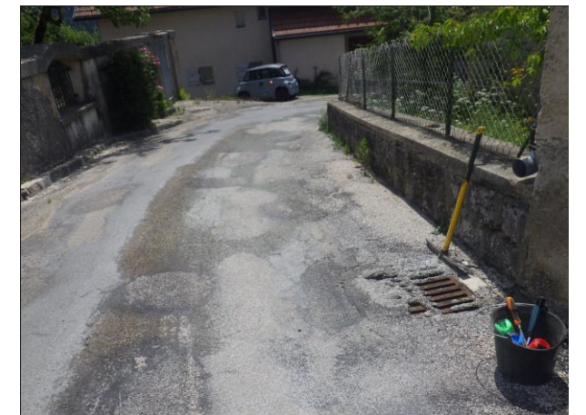
Réseau unitaire Rue des Remparts
