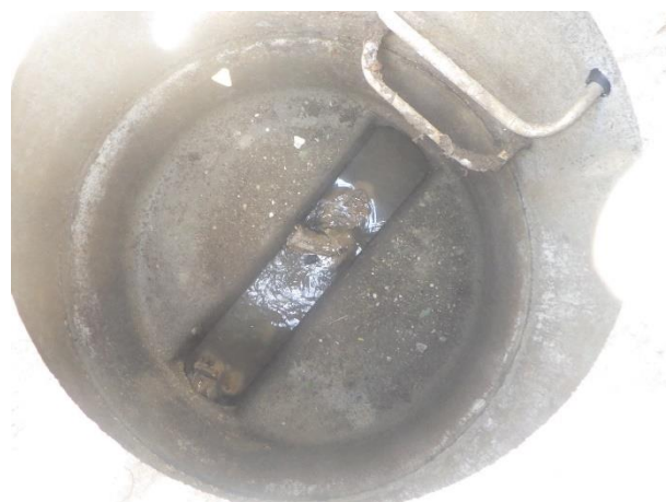
Le moulin - Présence de dépôts
