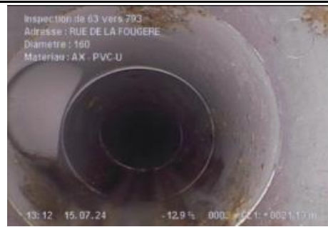
Raccordement par culotte - Ouvert à 9h
