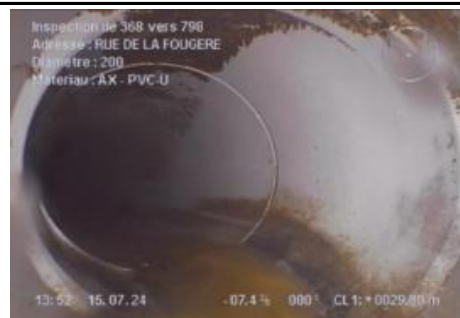
Courbure du collecteur vers la gauche - Angle 45°
