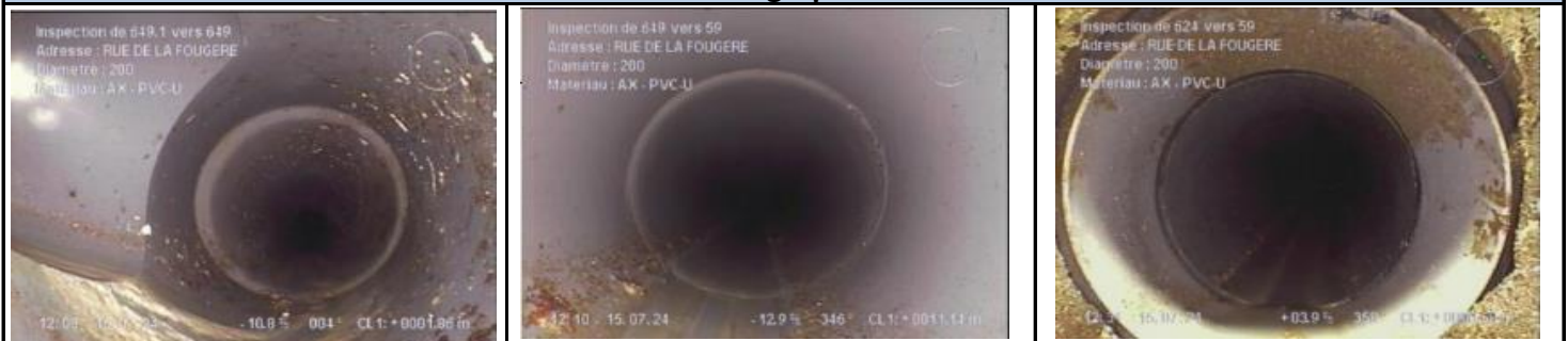
Raccordement par culotte - Ouvert à 9h
