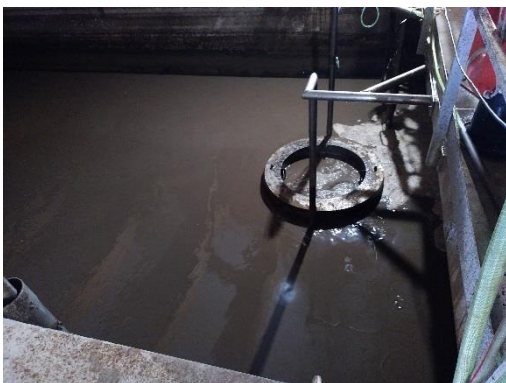
Résultat sur le bassin de traitement après 1 mois de traitement.
