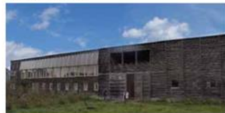
Utilisation des énergies renouvelables
