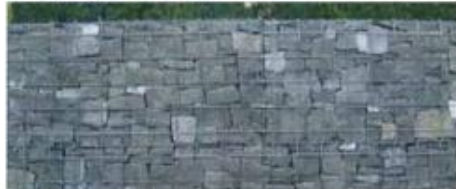
Des gabions comme alternative aux murs en pierres
