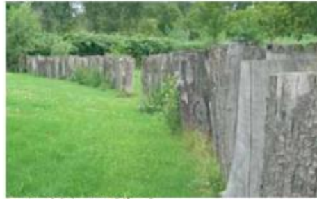
Des pieux de bois comme "clôture"
