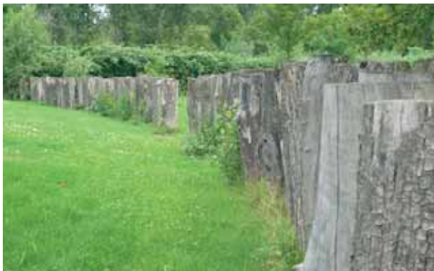
Des pieux de bois comme "clôture"
