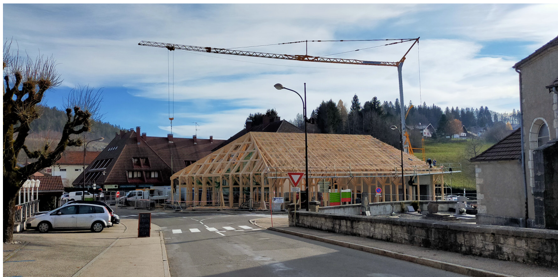
HALLE DE MARCHÉ EN COURS DE CONSTRUCTION
