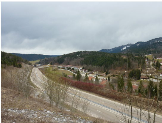
VUE SUR L'ENTRÉE SUD DEPUIS LA RN57
