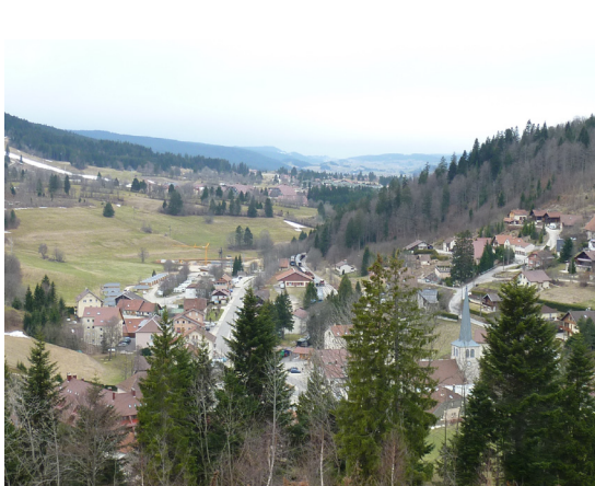
VUE SUR L'ENTRÉE OUEST ET PERSPECTIVE SUR MÉTABIEF
