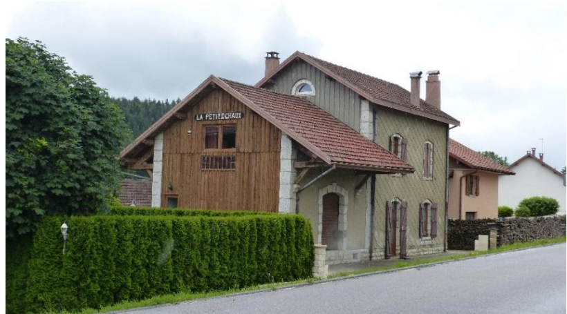
5. Ancienne gare de la commune
