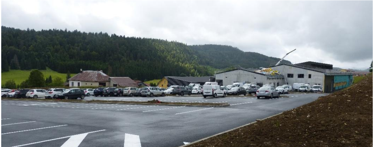
Vue sur l'entreprise en cours d'extension et le nouveau parking
