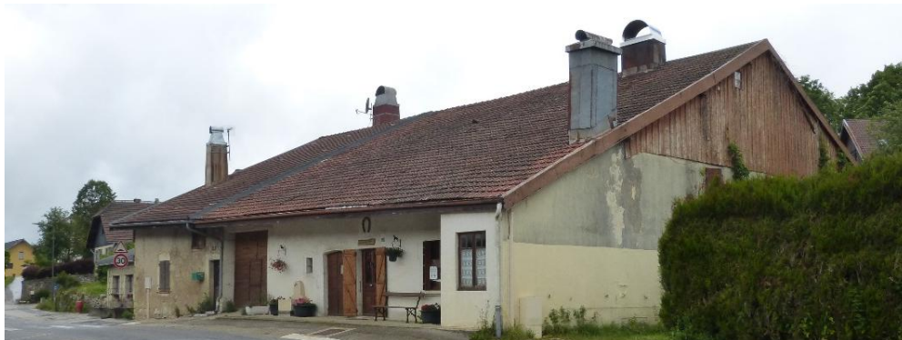
En partant de la droite : haie de séparation, façade sur rue sans clôture et muret de délimitation
