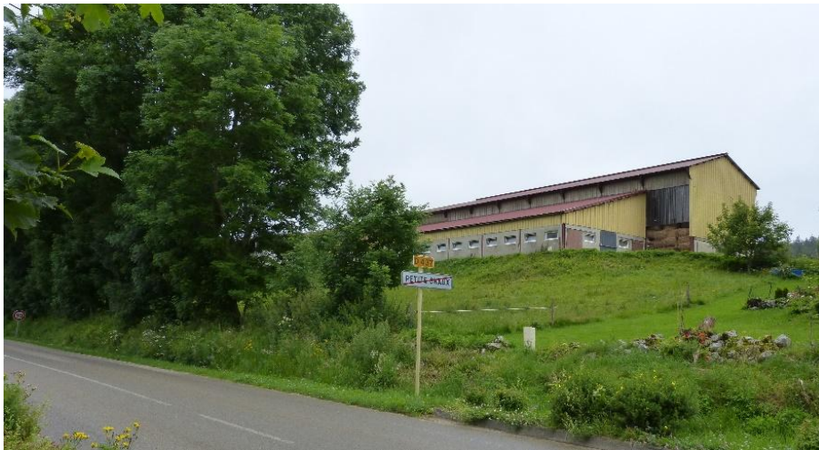
Exploitation agricole à l'Ouest
