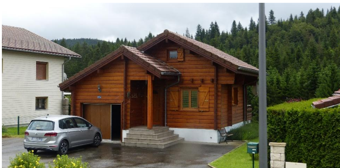
Construction récente de type chalet
