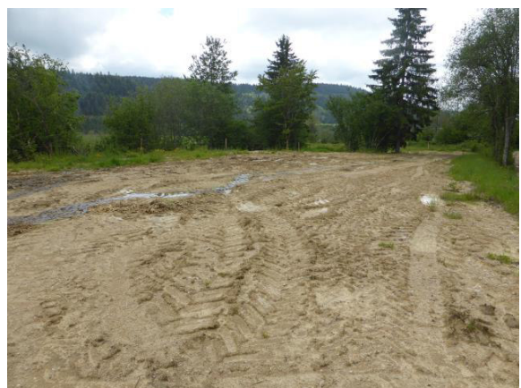
Remblai en lisière de forêt
