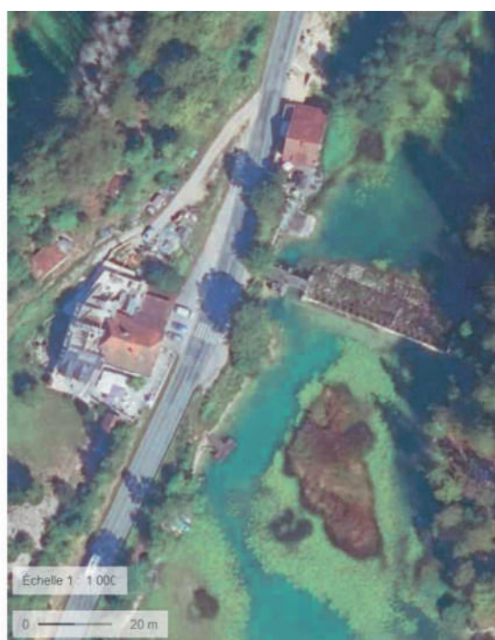
Figure 2 : Localisation du barrage à l'exutoire du lac de Saint-Point
