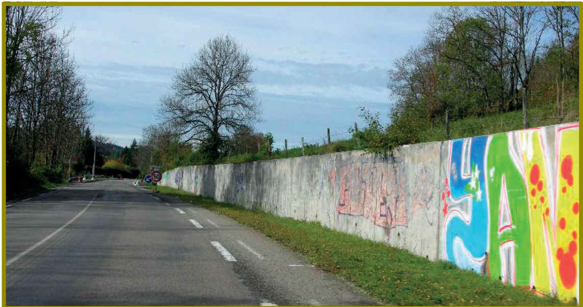
ENTRÉE PAR LA RD 437 DEPUIS PONTARLIER
