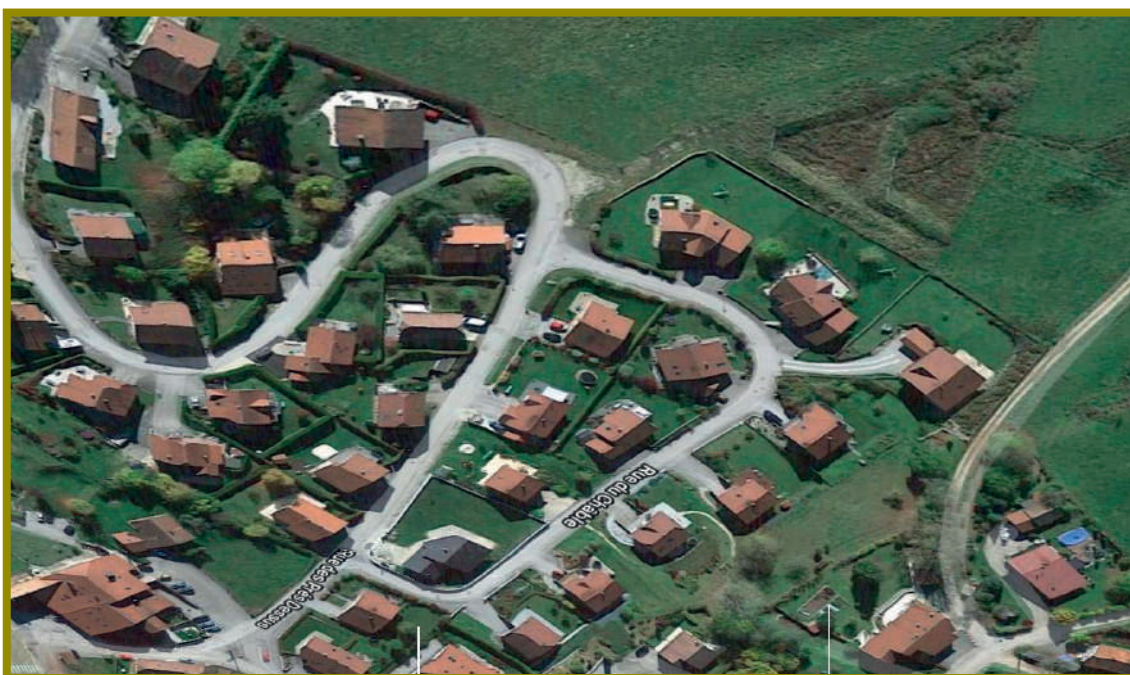
LES DERNIERS GRANDS ESPACES URBANISÉS DE LA COMMUNE (GOOGLE MAPS)
