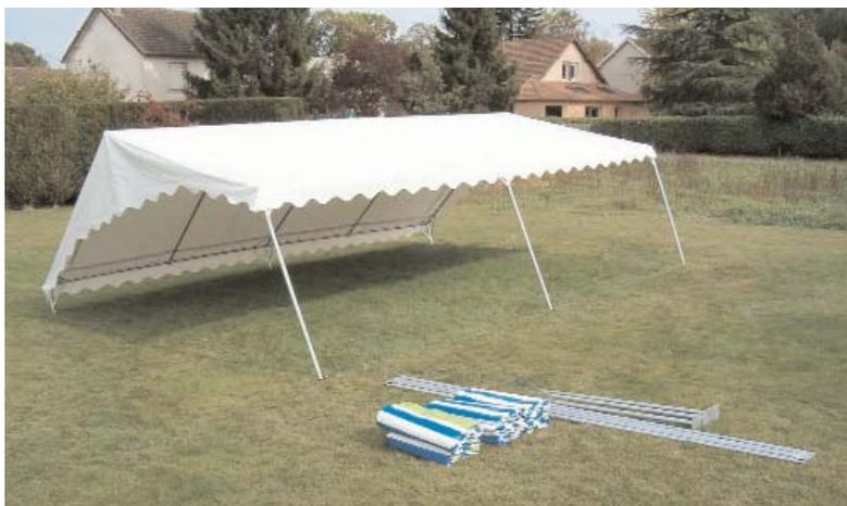
Le montage des poteaux se fait par basculement de la partie toiture de l'armature dans le sens de la longueur. Commencer par un côté puis le deuxième. Emboîter les poteaux sur les croisillons et boulonner à l'aide des vis poêlier 8 x 60 et des écrous papillon. Poser les barres de sol côté extérieur de l'armature et les boulonner aux pieds des poteaux à l'aide des vis poêlier 8 X 60 et des écrous papillon.
