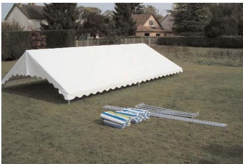
Une fois la bâche en position avec l'ensemble des angles emboîtant l'armature, mettre en tension à l'aide des élastiques. Ceux-ci se trouvant sur la bande à œillets du bas et devant faire le tour de la barre pour se reprendre à l'aide des crochets sur la bande à œillets du haut.
