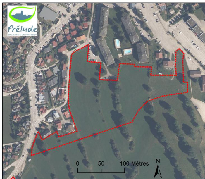
Vue aérienne 2013 (IGN) – Zone AUE de la Grande Raie
